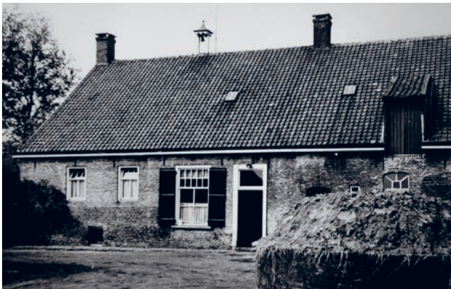
▲ De oostgevel opgetrokken uit de oude bakstenen.
